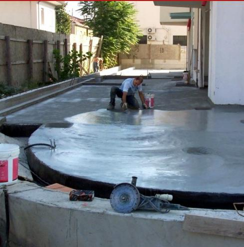
Hidroizolant ciment osmotic bicomponent în dispersie apoasă, polimer modificat, foarte flexibil și deformabil, cu comportament plasto-elastic. Aplicare cu mistrie, perie sau rolă. Ideal pentru hidroizolarea teraselor, balcoanelor și piscinelor, înainte de aşezarea pardoselilor din gresie sau faianță. Potrivit pentru contactul cu apa potabilă.
