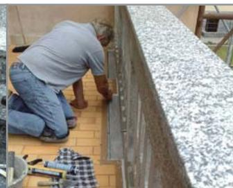
2) Preparazione dei giunti strutturali di movimento e loro sigillatura con PROTECH FLEX
